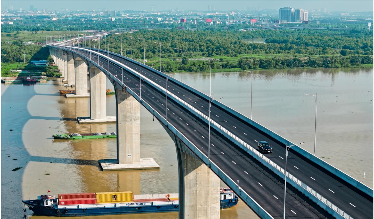
ドンナイ省とホーチミン市を結ぶニョンチャック橋は、2025 年 8 月 19 日に開通。
